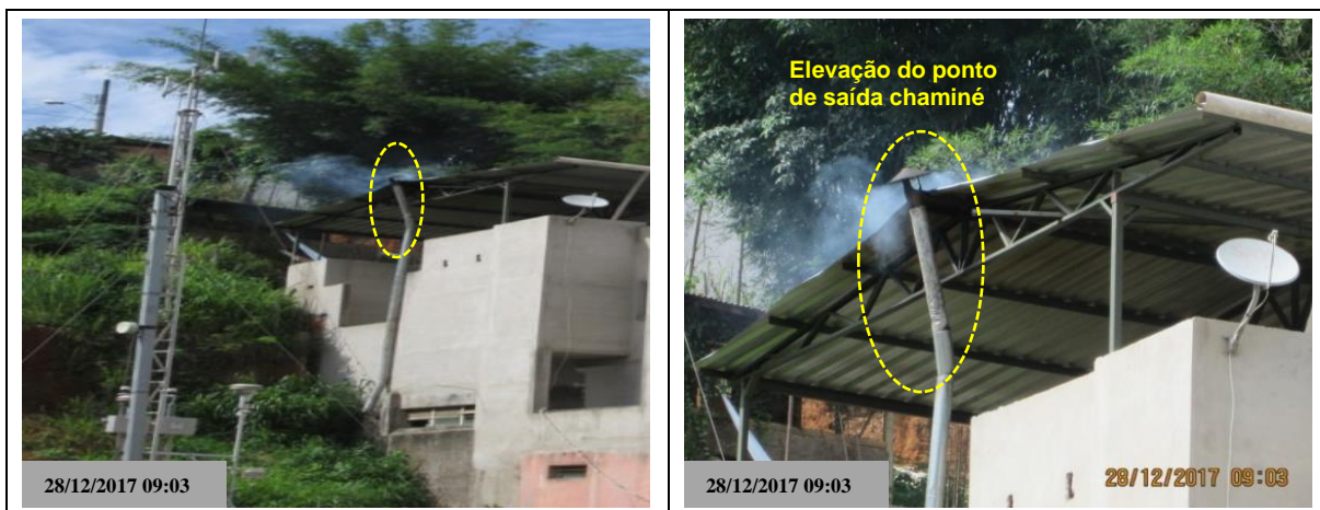
Figura 5.8 - Registro da Chaminé da Padaria Após Nova Alteração da Altura – Dezembro/2017
