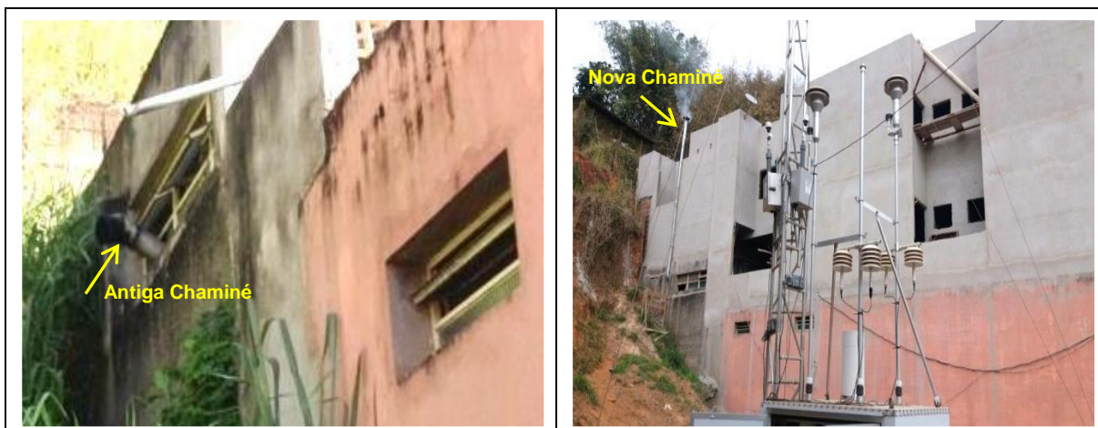
Figura 5.7 - Registros da Antiga e da Nova Chaminé da Padaria
